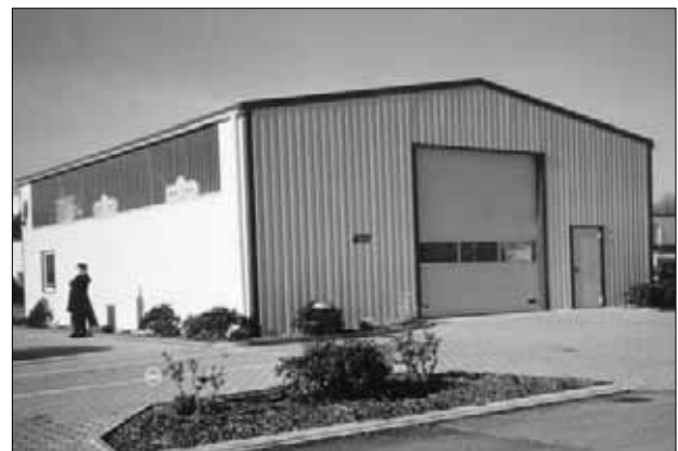
Halle wie abgebildet: Breite 12,50 m x Länge 20,00 m x 4,50 m Traufe
